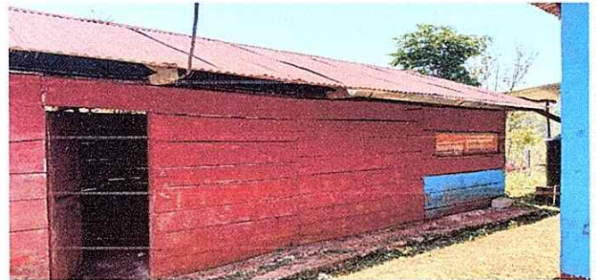
Foto 6: CAMBIO DE ENTECHADO DE COCINA EN MAL ESTADO. MODULO 2
